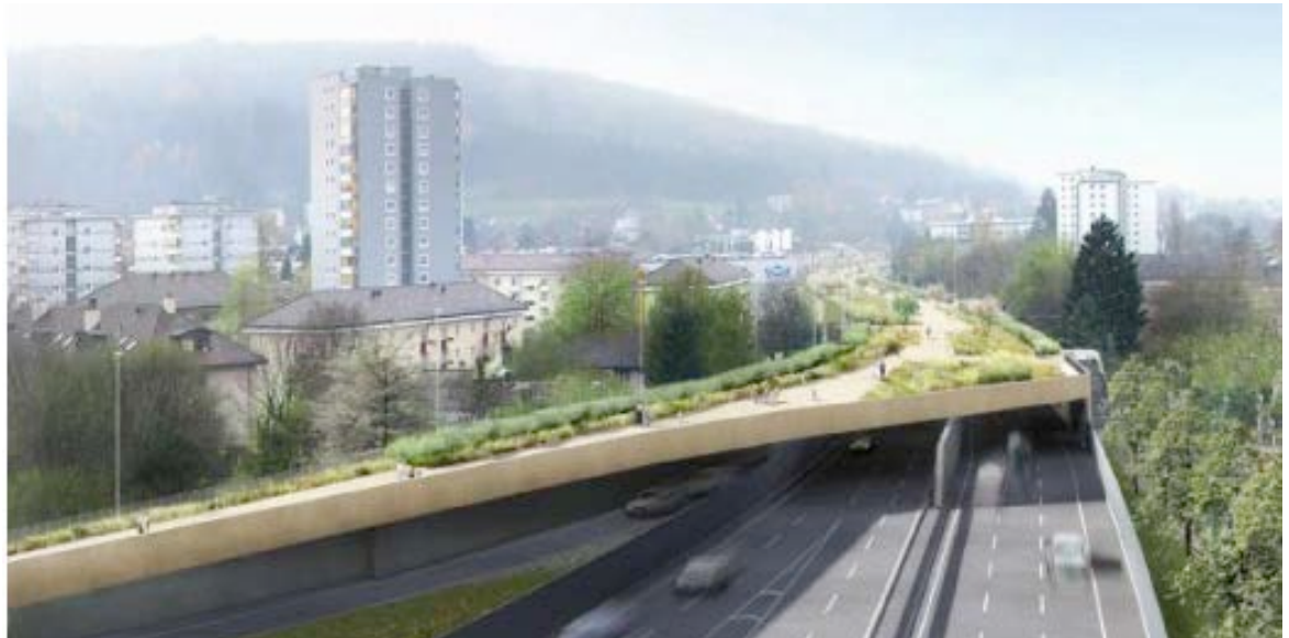
Tunneleinhausung, Visualisierung Aubrugg
