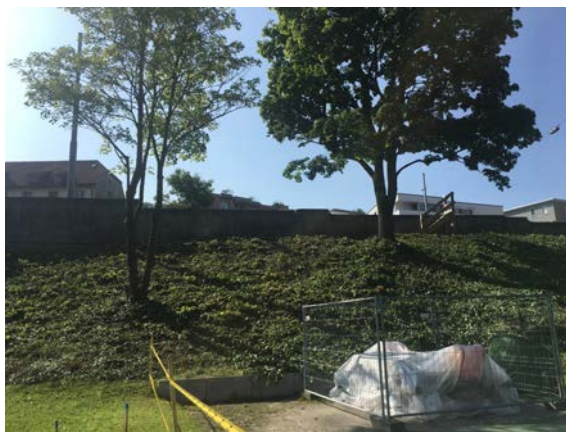
Teilgebiet B18 Blick zur Schwamendingerstrasse
