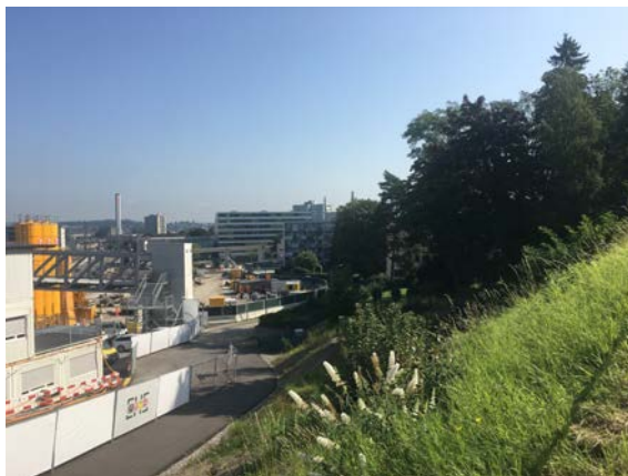
Teilgebiet B15 (Bauplatzinstallation)
