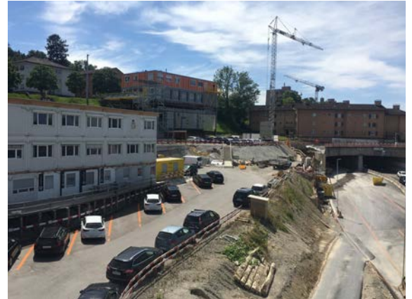
Von Einhausung auf Teilgebiet B15 (Bauplatzinstallation)
