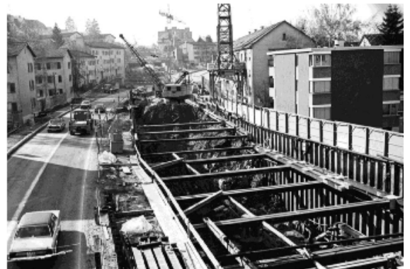
Bau der Stadtautobahn 1977
