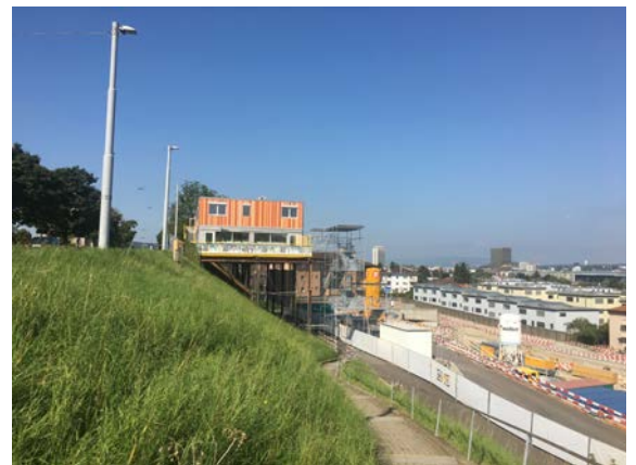
Teilgebiet B15 (Bauplatzinstallation)
