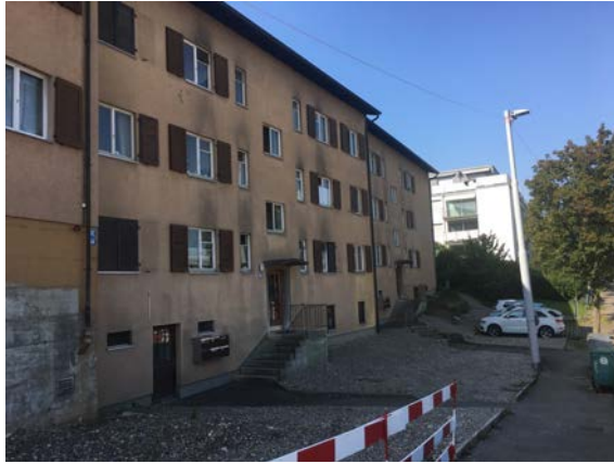
Teilgebiet B18 Gebäude an Ueberlandstrasse (1947)
